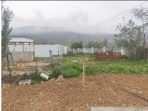
临时占地恢复
